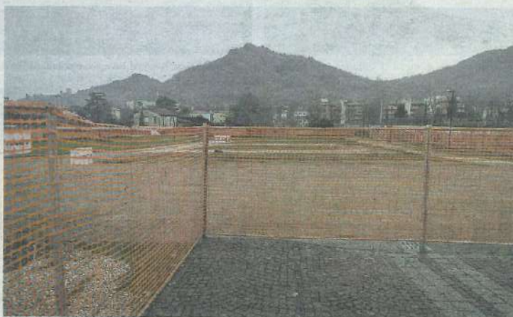
CAMPUS SCOLASTICO Allestito il cantiere per la costruzione della palestra a disposizione dell'Istituto Beltrame a anche delle società. In comune investe 550mila euro in alto Antonio Miatto (Nirve Tecniche) TORRES
